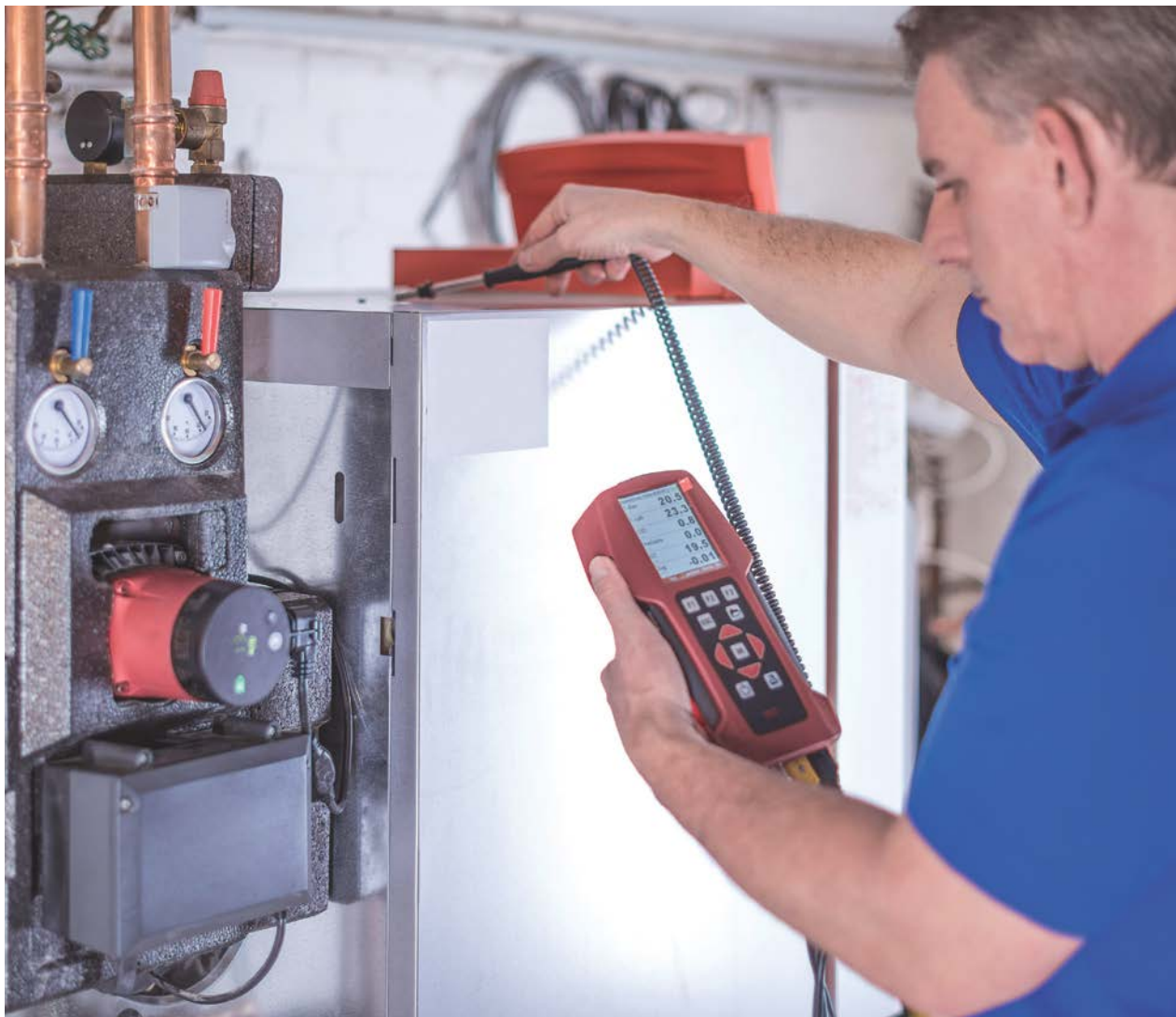
Um einen Wärmeverlust feststellen zu können, wird die Kesseloberfläche mit einem Oberflächentemperaturfühler abgetastet. Je wärmer die Kesseloberfläche, desto schlechter fallen die Bewertungspunkte aus.
