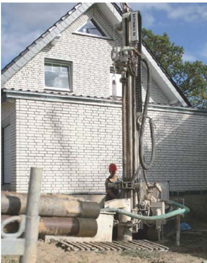
Fachgerechte Planung und der Einsatz professioneller Bohrtechnik sind entscheidend. Foto: Wärme+/Stiebel Eltron
